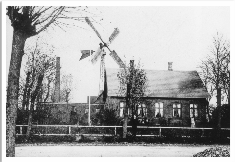
Kjærbyes uldspinderi i 1913. Der var både dampmaskine og vindmølle til spinderiet. Når der ikke var rigtig vind skete det somme tider, at det hele gik i stå. Så måtte man have petroleumslampen frem. Der var kun elektrisk lys, når møllen gik.
